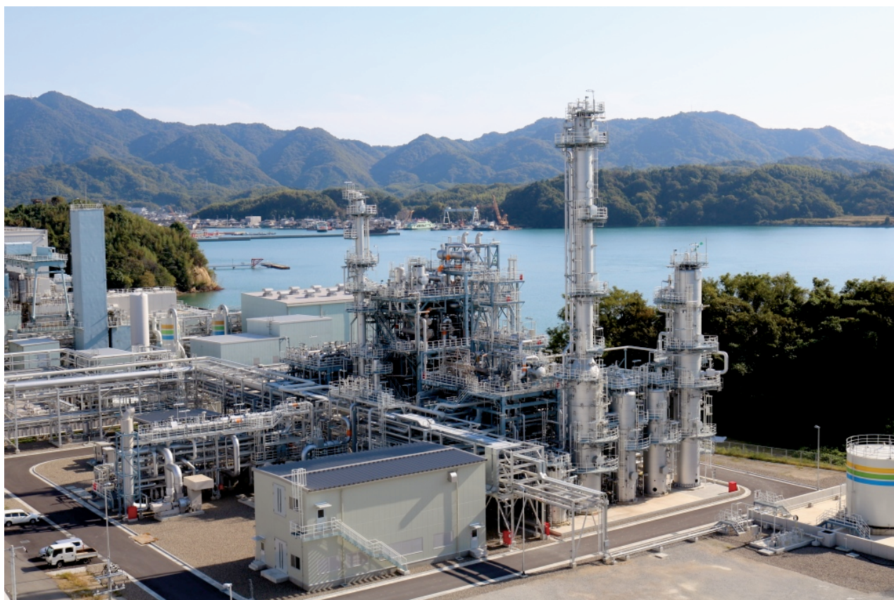
図1 第2段階のCO 2 分離・回収型酸素吹IGCC実証試験のCO 2 分離・回収設備 (中国電力(株)大崎発電所内)
